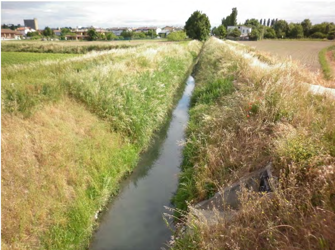
Foto 6: Scolo Cannella dove è previsto il manufatto M.01.
