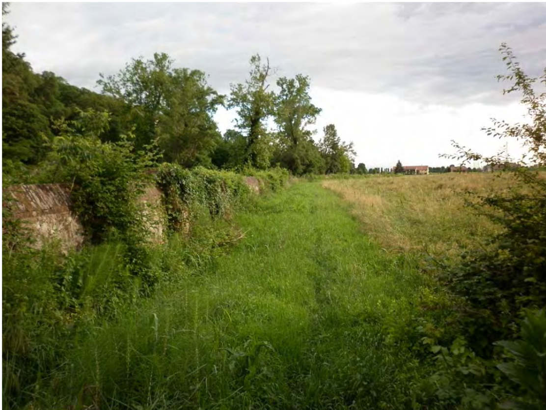
Foto 2: Particolare dell'area di prevista realizzazione del rialzo dove è visibile parte del muro esistente.
